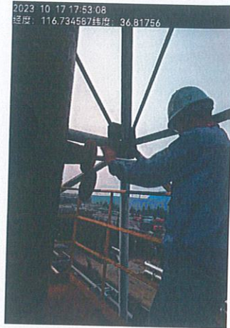
脱硫废液制酸排气筒 (DA062)
