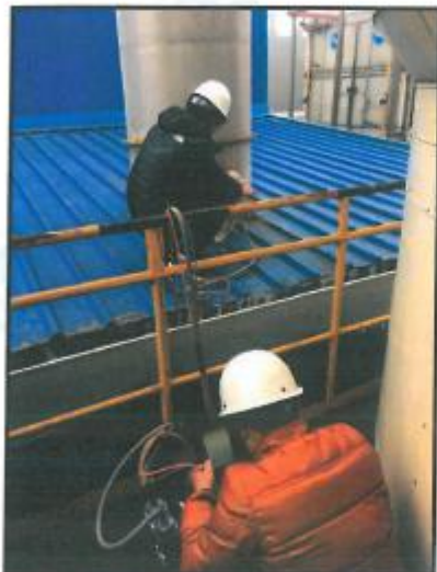
附图 1：水膜除尘废气排气筒采样
