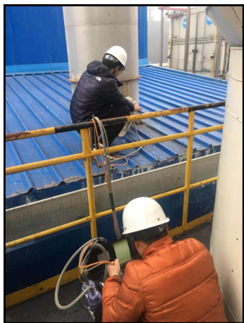
文丘里除尘器废气排气筒采样
